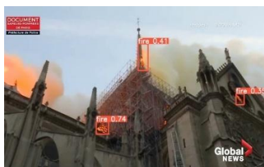
Localisation de feu
